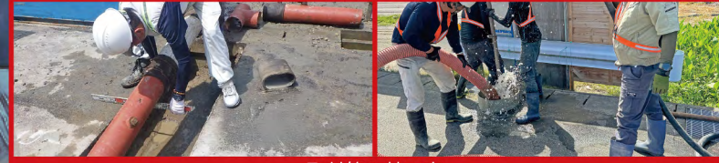
取付管入替工事
